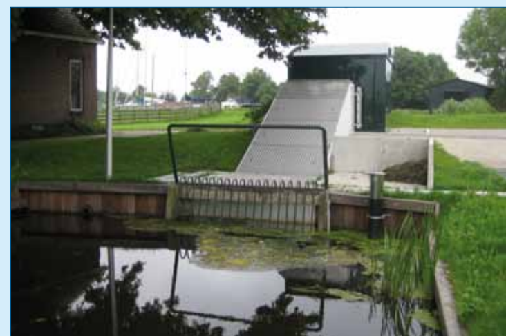
Figuur 3. Gemaal Boterhuispolder een van de gemalen van het Hoogheemraadschap van Rijnland.
