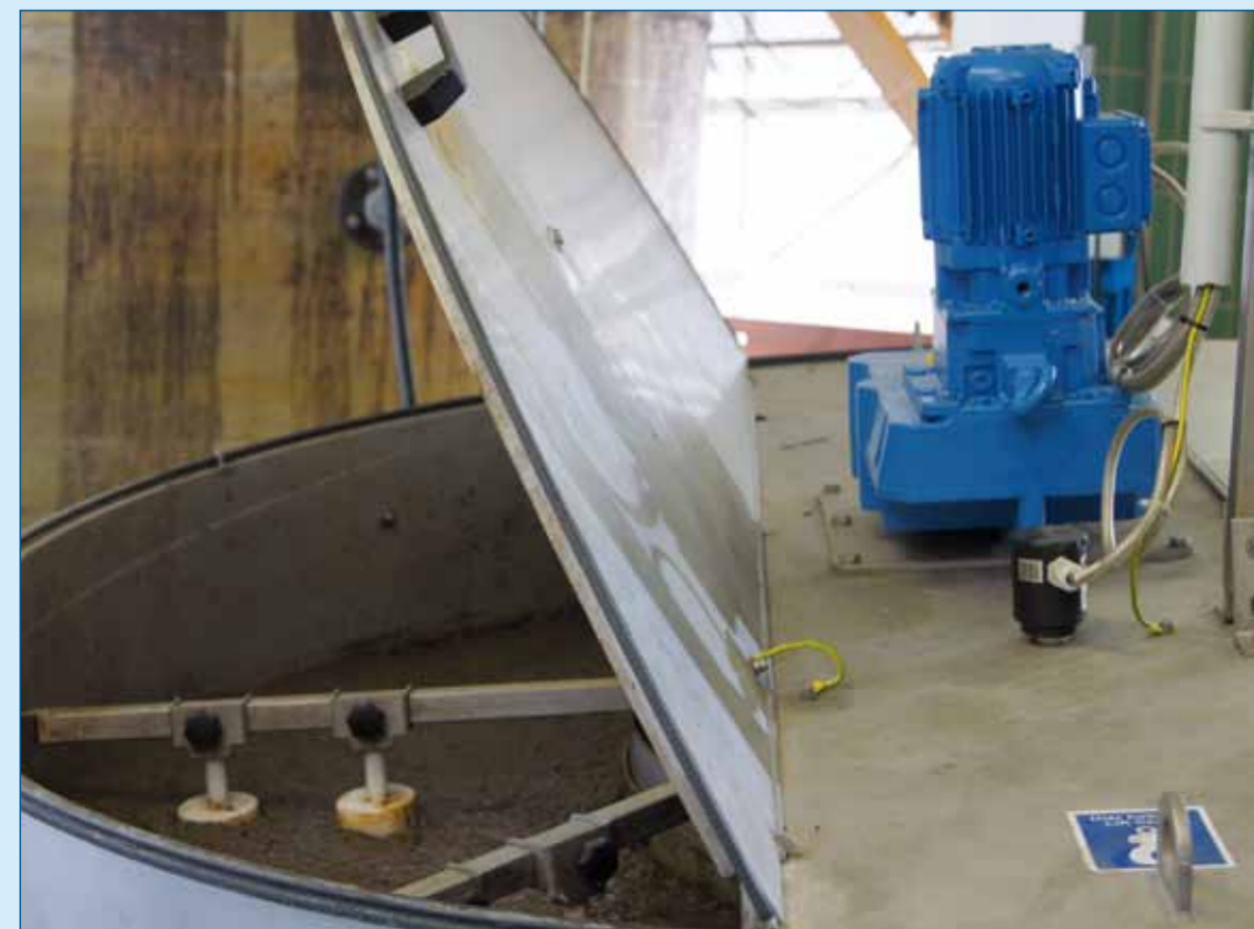
Figuur 2. Eén van de twee motoren in de opstelling in een Duitse waterzuiveringsinstallatie waarmee is aangetoond dat met een moderne motor met permanente magneten 40% energie bespaard kan worden.
