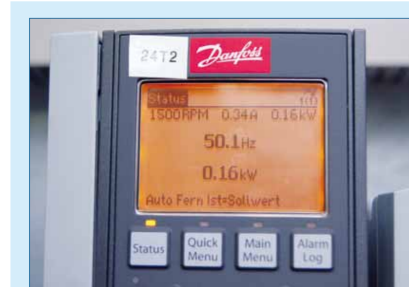
Figuur 2. Eén van de twee motoren in de opstelling in een Duitse waterzuiveringsinstallatie waarmee is aangetoond dat met een moderne motor met permanente magneten 40% energie bespaard kan worden.
