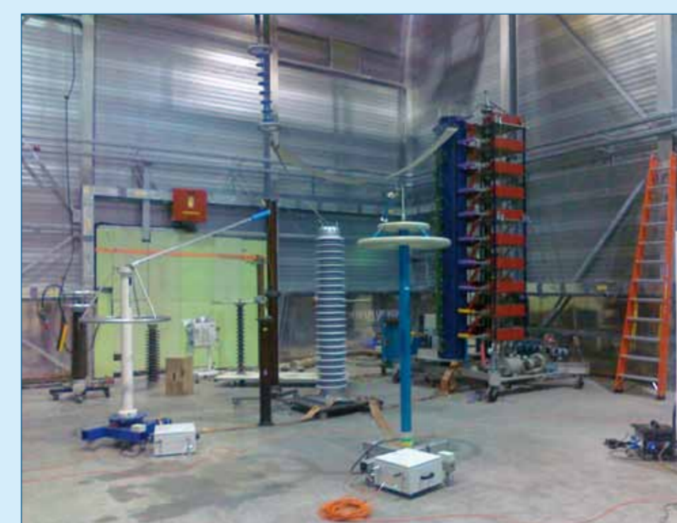
Afbeelding 2. Testopstelling voor de kalibratie van een 700 kV divider met stootspanningsgenerator 1 MV. Bij de voet van de delers staan de EMC-boxen met HBM transmitters.
