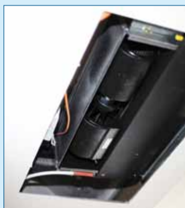
Afbeelding 1. De EC centrifugaal ventilatoren zijn beschikbaar in enkele, dubbele en driedubbele uitvoering, met een vermogensbereik tot 250 W en een luchtdebiet tot 2.500 m 3 per uur.
