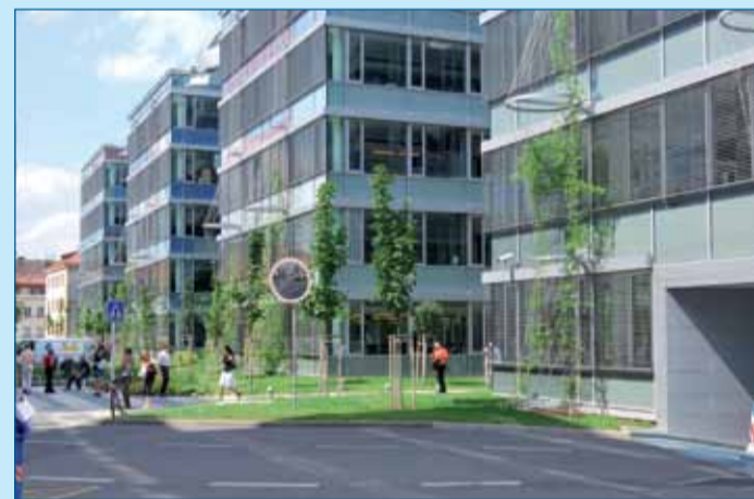
Foto 2: Het hoofdkwartier van het grootste verzekeringskantoor in Tsjechië bereikte een verbeterde energiebalans van 60% dankzij geïntegreerde automatisering van alle gebouwfuncties via KNX.
