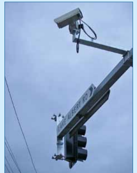
Figuur 1. De videocamera boven de weg kan met een frame grabber ook gebruikt worden voor het vaststellen van snelheidsovertredingen.
