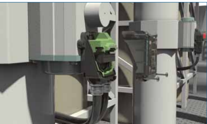
Figuur 1. Het sensorelement, het groene blokje is in een transparante waterdichte behuizing ondergebracht.
