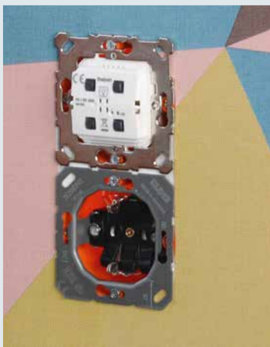
Afbeelding 1. De elektronische schakelaar met KNX-RF en bediening ter plekke.
